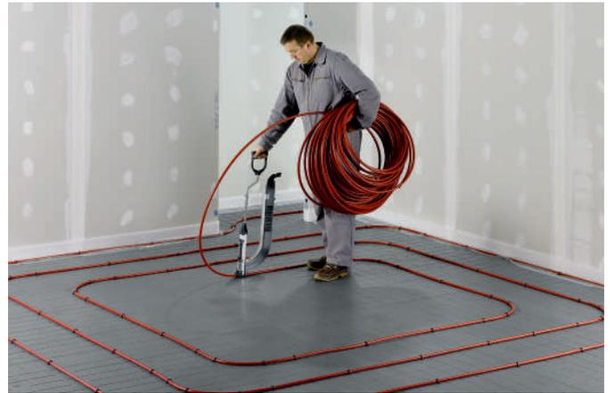
Fig. 3 Pose du tube
