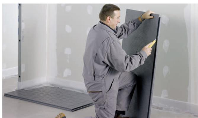
Fig. 1 Pose des dalles planes DALPLAN et RAUPUR en coupant les tenons mortaises
